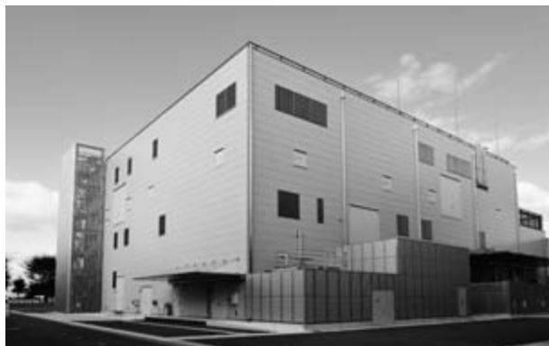
高崎工場・バイオ医薬原薬製造設備
