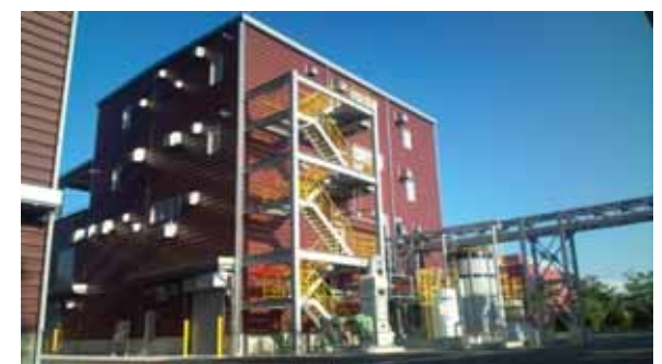
原薬製造棟 (22工場)
