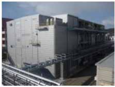
原薬製造棟 (20工場)
