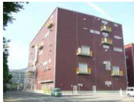
原薬製造棟 (21工場)
