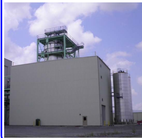
BIOKYOWA 新製造設備 (3月完工)
