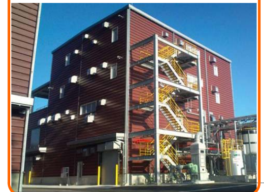
第一ファインケミカル 22工場 (7月完工)
