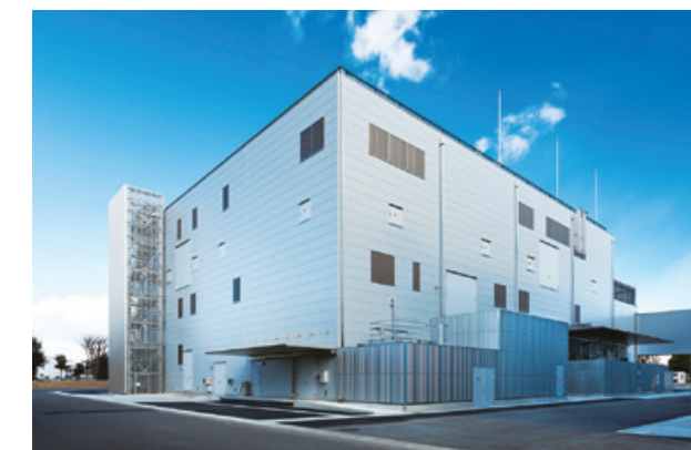
高崎工場に竣工した新しいバイオ医薬品原薬生産設備
